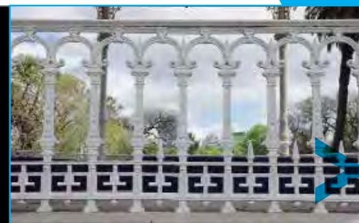
Herrería artística de las barandas perimetrales.
