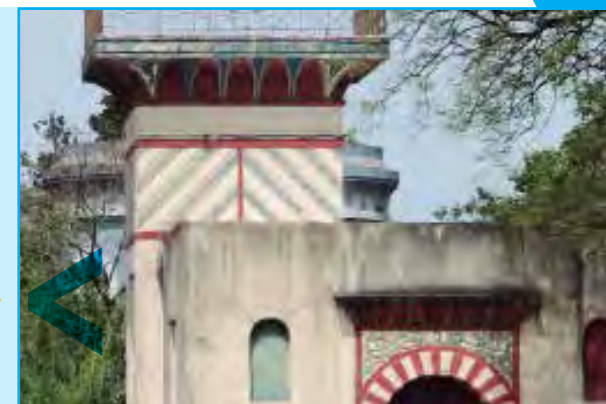
Vista de la torre lateral que conforma la fachada.
