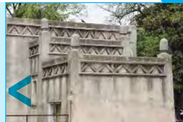
Vista del escalonamiento de los volúmenes que componen el edificio.
