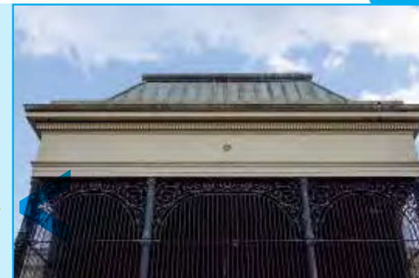
Herrería ornamental que cierra los recintos externos.
